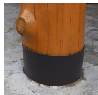
(完了・ガラスコティング工法)
