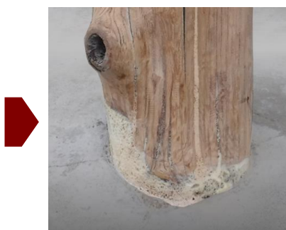
(腐食除去・洗浄・殺菌・保護)
