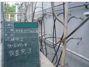
擁壁のASR補修事例
