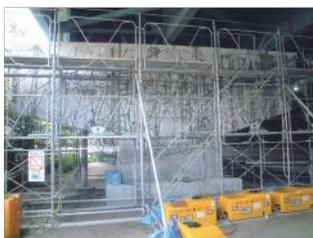
橋脚 (はり部) のASR補修事例
