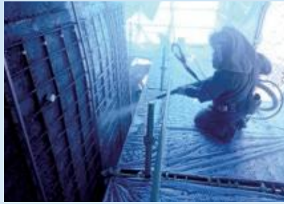
橋脚耐震補強
