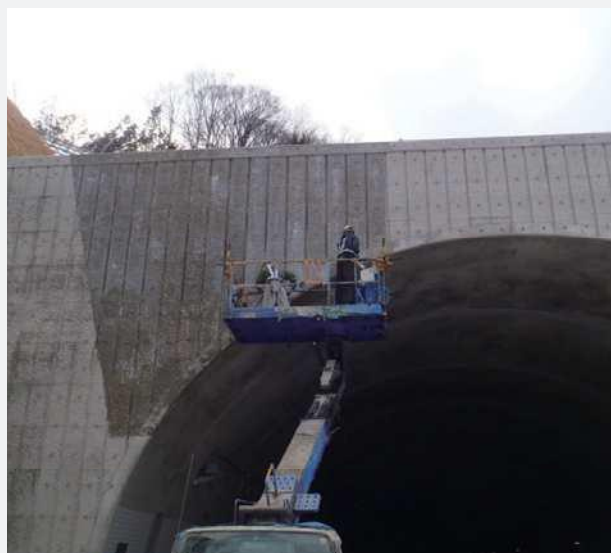
トンネル坑口
