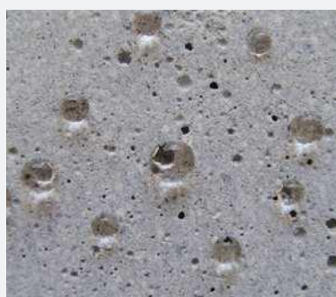
塗布後のコンクリート表面
