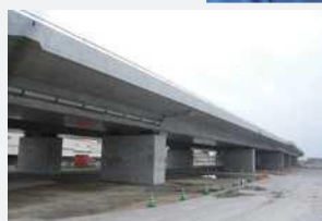
橋梁橋脚(塗布状況)
