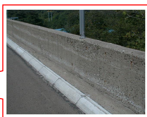
東北道、八幡平出口近くのスケーリングを起こしている高欄。
