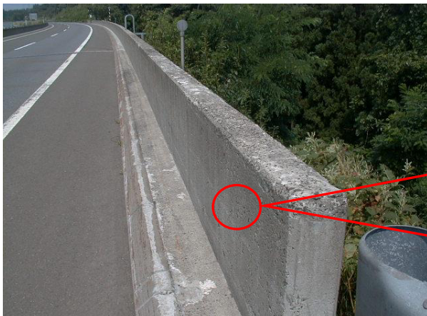
東北道、八幡平出口近くのスケーリングを起こしている高欄。
