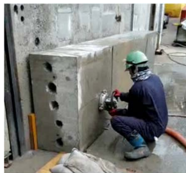
WJ工法による表面処理
