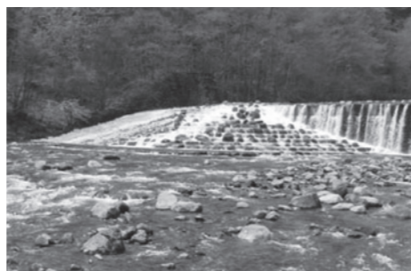
改良された床固めの魚道
